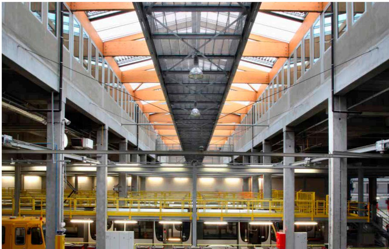
**RÉALISATION** Installation électrique complète d'un nouveau hall d'entretien pour trams. Livraison et installation d'une nouvelle cabine MT, livraison et montage de l'installation électrique Basse Tension inclus : TGBT, tableaux divisionnaires, éclairage, vidéosurveillance, sonorisation, contrôle d'accès, détection incendie, fourniture et installation de contacteurs 750V DC pour alimenter la caténaire.
